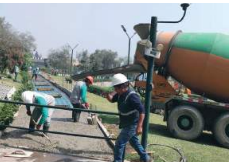
↓ Encofrado de acequia
