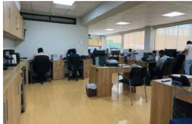
↑ Implementación de cableado estructurado de datos, sistema de videovigilancia y equipos de acceso inalámbrico para las nuevas oficinas administrativas
