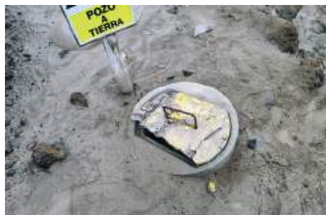
⬆ Mantenimiento correctivo. Cambio de 24 bóvedas de pozos a tierra
