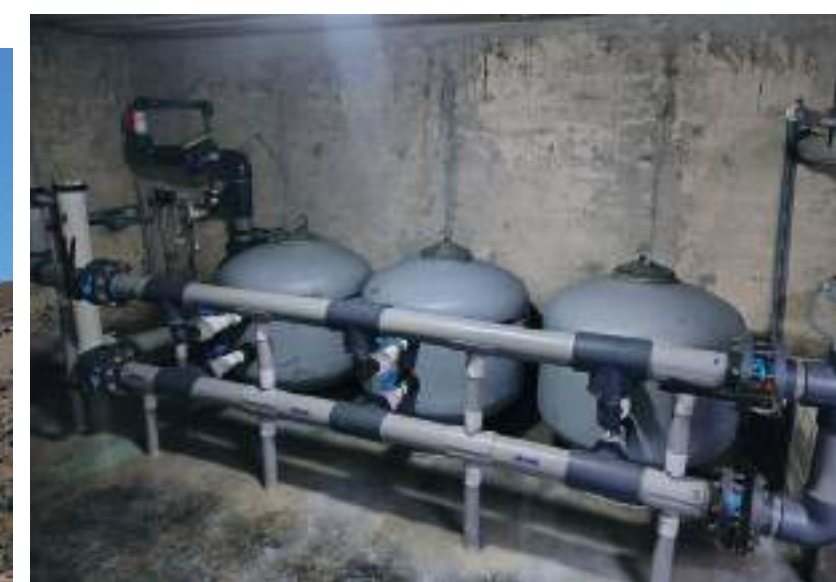
↑ Mantenimiento de 3 bombas de 3 hp
