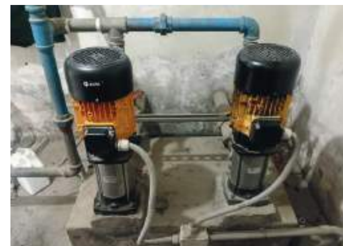
↑ Compra e instalación de una electrobomba para el tanque hidroneumático
