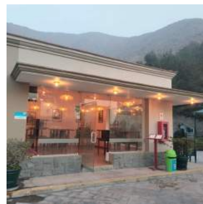
▼ Instalación de luminarias en el restaurante
