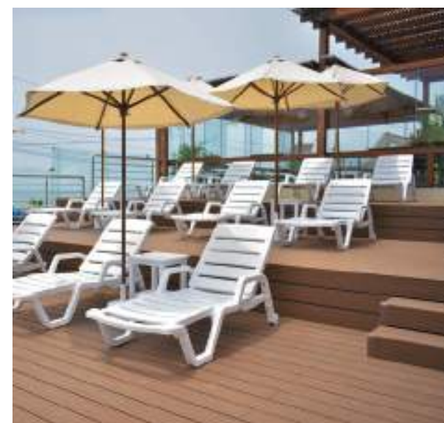
↑ Instalación de piso deck
