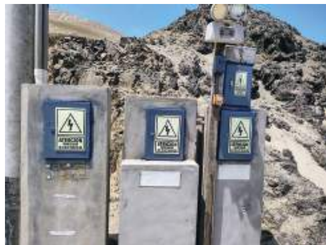
⬆ Mantenimiento preventivo de 23 tableros eléctricos de baja tensión
