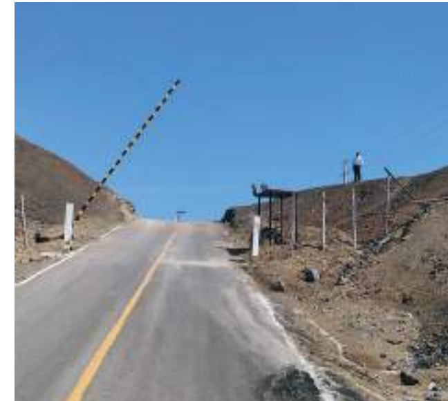
↓ Instalación de tranquera en ingreso del Club PV2
