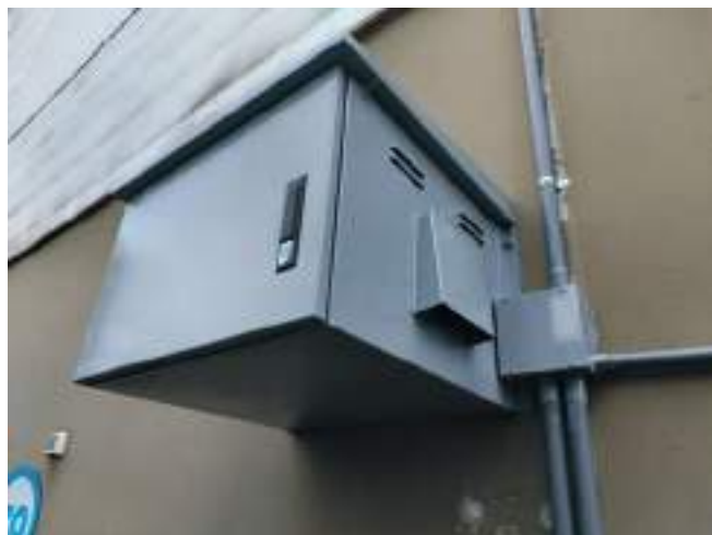
↓ Implementación de nuevo cableado estructurado de datos con gabinetes herméticos para la playa de estacionamiento
