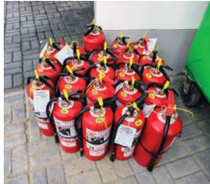
↓ Recarga de extintores
