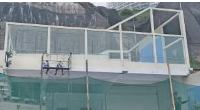
▼ Demolición y habilitación de vigas y columnas cancha de frontón N.º 3
