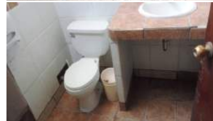
↑ Renovación de la red de agua y desagüe en el bungalow N.º 6
