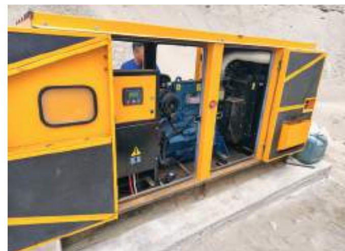
⬆ Mantenimiento preventivo de grupo electrógeno
