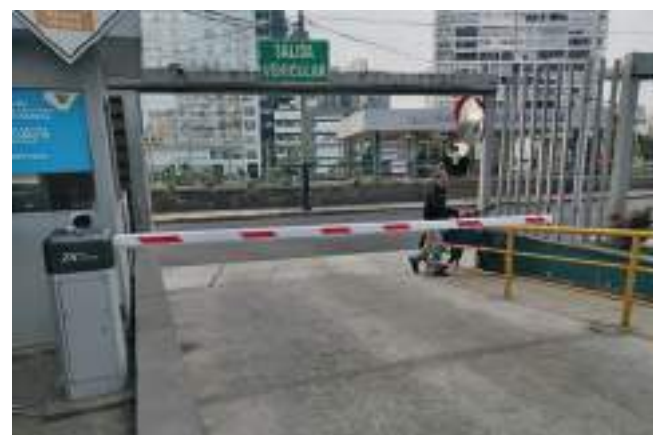
↑ Implementación de nuevas cámaras IPR en la playa de estacionamiento
