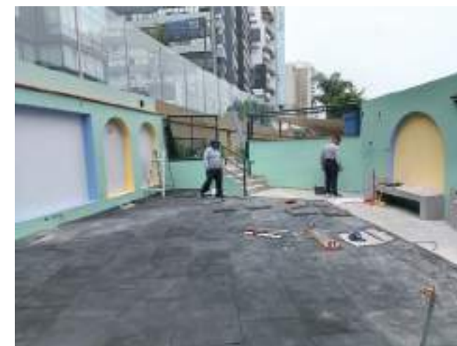
↓ Implementación de cableado estructurado de datos en la zona de niños de 6 a 10 años
