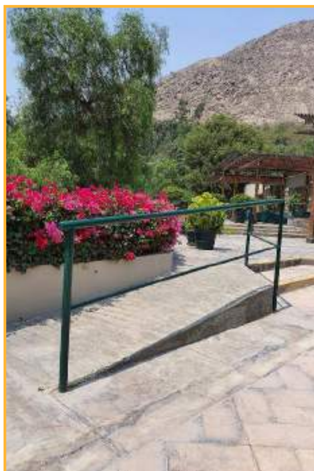
CONSTRUCCIÓN DE RAMPAS DE ACCESO PARA DISCAPACITADOS CON BARANDAS DE FIERRO
