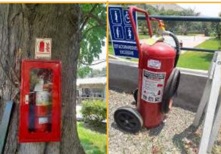
RECARGA DE EXTINTORES E INSTALACIÓN DE EXTINTORES EN EL CAMPO POR RECOMENDACIÓN DEL INDECI
