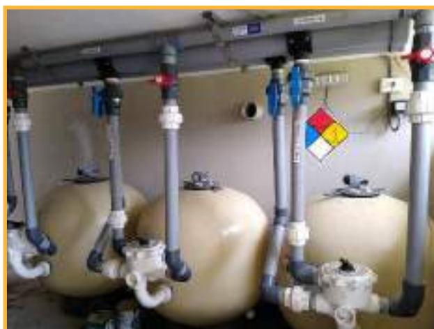
MANTENIMIENTO DE LA SALA DE BOMBAS DE LA PISCINA
