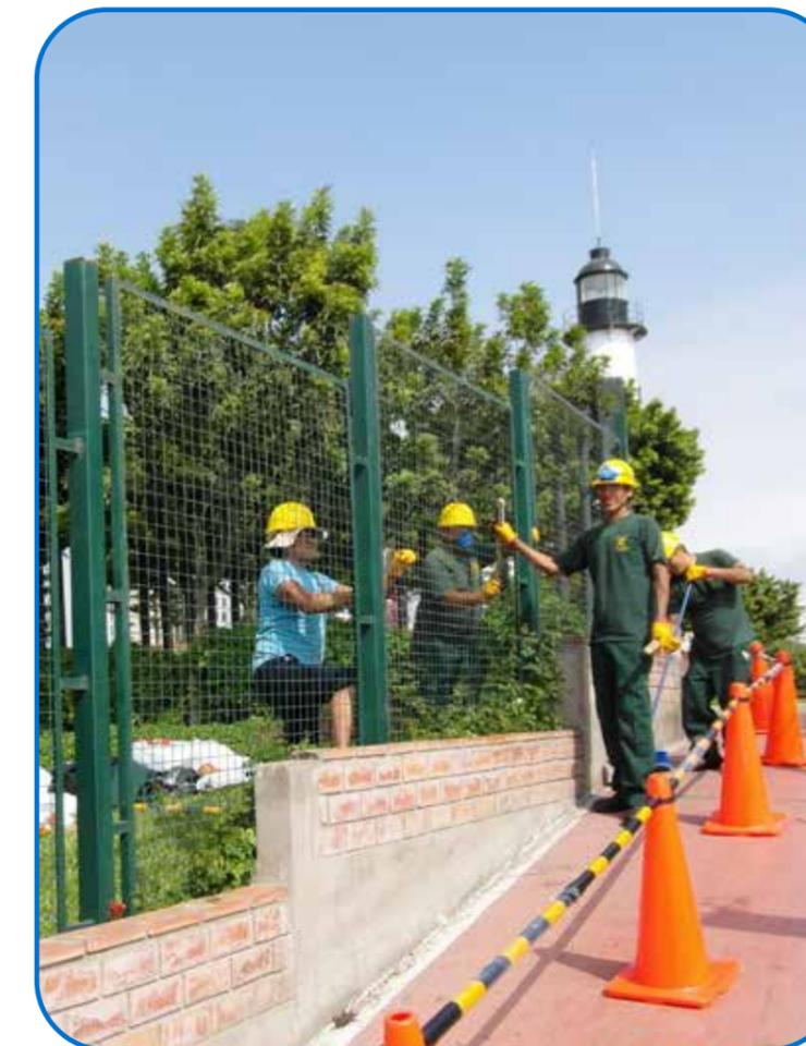
Los trabajos consistieron en el retiro de la pintura de la plataforma de la ciclovía; resane de sobrecimientos; mantenimiento de mallas metálicas (lijado y pintado); mantenimiento de las instalaciones eléctricas (verificación de operatividad); mantenimiento y pintado de postes metálicos de luminarias y señales informativas; pintura nueva en ciclovía y pintura en señales horizontales.
