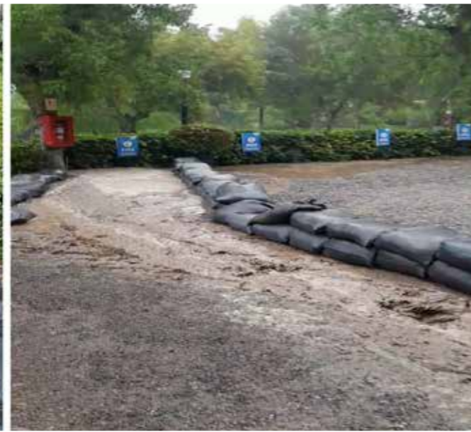
ELABORACIÓN DE COSTALILLOS CON ARENA PARA DELIMITAR MUROS DE CONTENCIÓN Y ENCAUZAR POSIBLES DESLIZAMIENTOS.
