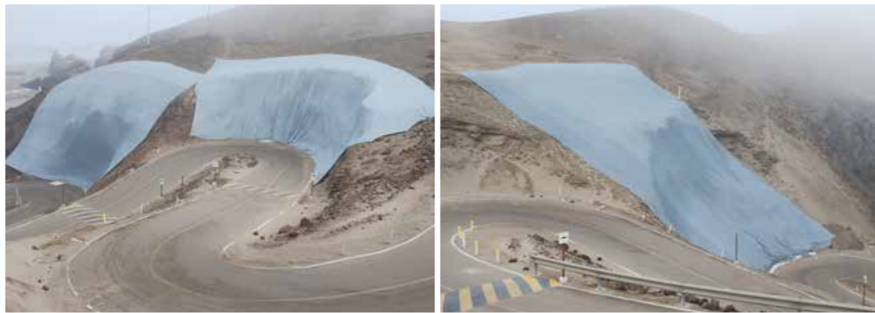
CAMBIO DE MALLAS RASCHEL EN LAS LADERAS DE LOS CERROS DE LA PLAYA 2
