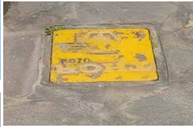
IMPLEMENTACIÓN DE 8 POZOS A TIERRA
