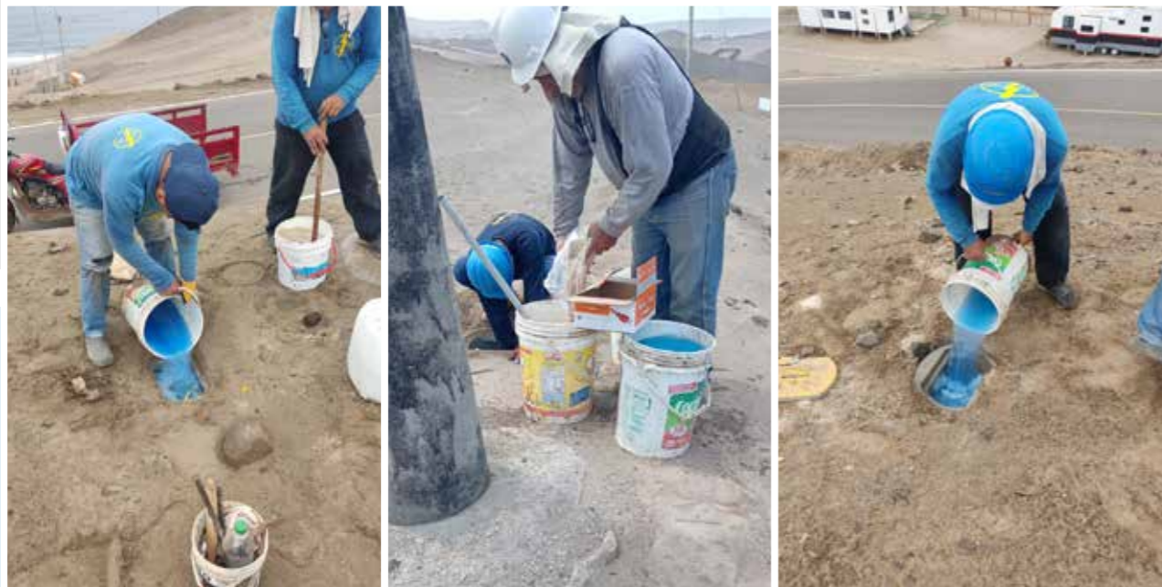
MANTENIMIENTO PREVENTIVO DE 27 POZOS A TIERRA
