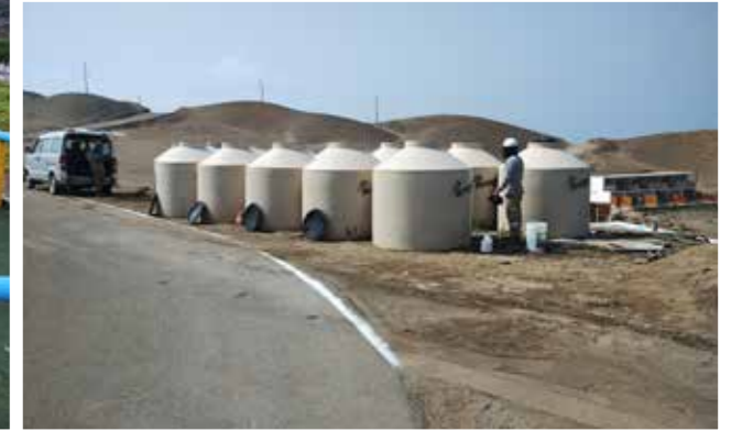
LIMPIEZA, DESINFECCIÓN Y CERTIFICACIÓN DE 25 TANQUES ROTOPLAS PARA ALMACENAMIENTO DE AGUA
