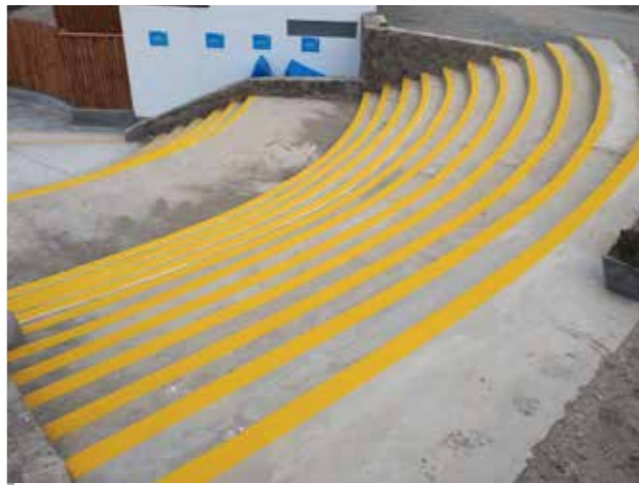
PINTADO DE GRADAS DE ESCALERAS
