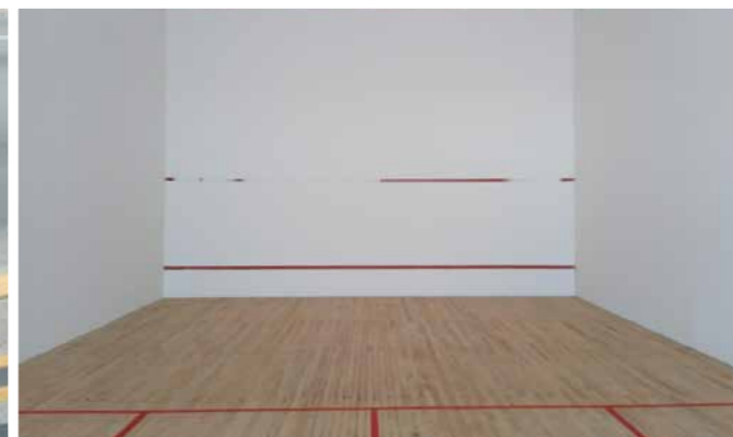
MANTENIMIENTO DE LAS CANCHAS DE SQUASH N° 1 Y N° 2 (PULIDO DE PISO, PINTADO DE PAREDES Y LÍNEAS DE CANCHA)
