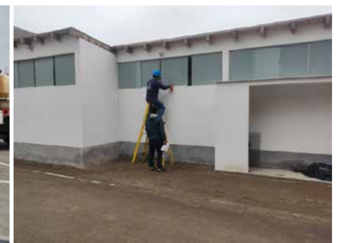
MANTENIMIENTO DE VENTANAS DE CAMERINO DE DAMAS Y CABALLEROS UBICADOS EN LAS PLAYAS PERCEBES Y PAJARITOS
