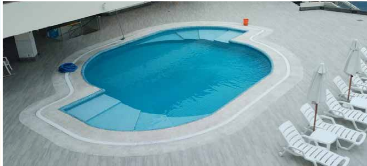
CAMBIO DE LA REJILLA DE REBOSE DE LA PISCINA CHICA UBICADA EN EL SEGUNDO NIVEL
