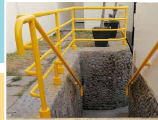
INSTALACIÓN DE BARANDA EN LA ZONA DE PARRILLA
