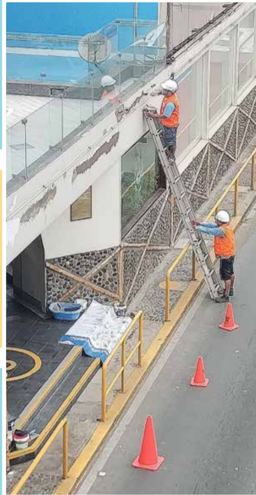
LIMPIEZA Y MANTENIMIENTO DE LA FACHADA (VIDRIOS ALTOS Y ENCHAPE DE PIEDRA DE CANTO RODADO)
