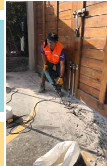
INSTALACIÓN DE CANALETA, REJILLA DE METAL Y CAJA DE DESAGÜE PARA EVITAR ANIEGOS EXTERNOS EN ZONA DE PARRILLA
