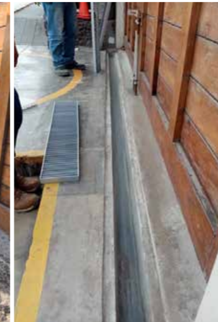
INSTALACIÓN DE CANALETA, REJILLA DE METAL Y CAJA DE DESAGÜE PARA EVITAR ANIEGOS EXTERNOS EN ZONA DE PARRILLA
