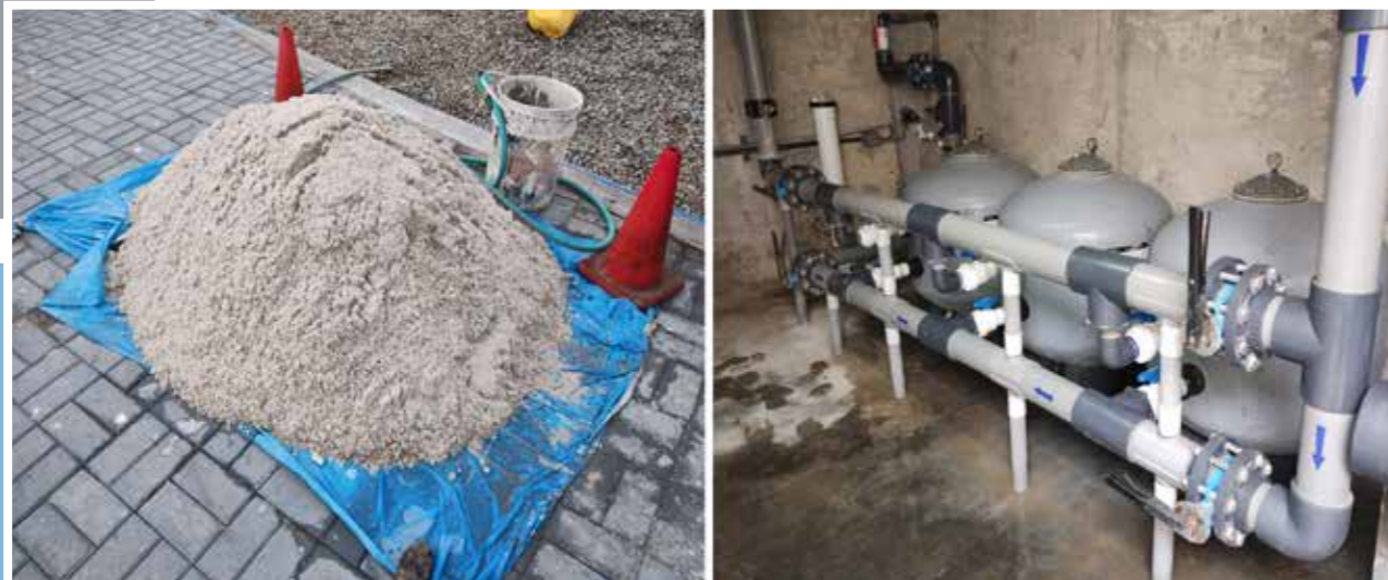
CAMBIO DE ELEMENTO FILTRANTE DE LOS FILTROS DE PISCINAS
