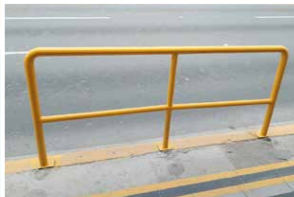
MANTENIMIENTO DE LA BARANDA DE SEGURIDAD VIAL EXTERIOR
