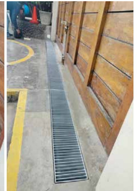
INSTALACIÓN DE CANALETA, REJILLA DE METAL Y CAJA DE DESAGÜE PARA EVITAR ANIEGOS EXTERNOS EN ZONA DE PARRILLA
