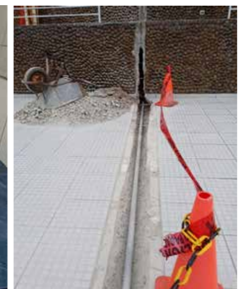
REPARACIÓN DE FUGA DE AGUA EN LA TERRAZA N° 2
