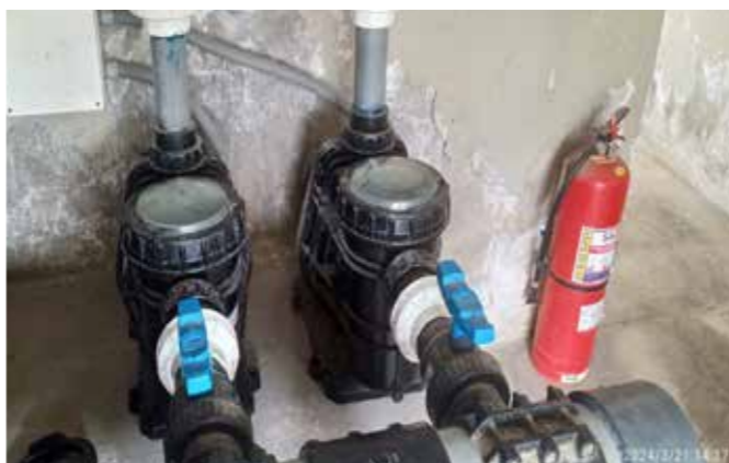
MANTENIMIENTO PREVENTIVO DE ELECTROBOMBAS
