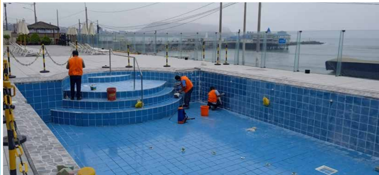
MANTENIMIENTO GENERAL DE LA PISCINA DE ADULTOS (CAMBIO DE AGUA, FRAGUA, LIMPIEZA DE LUMINARIA Y REPARACIÓN DE CANALETAS)
