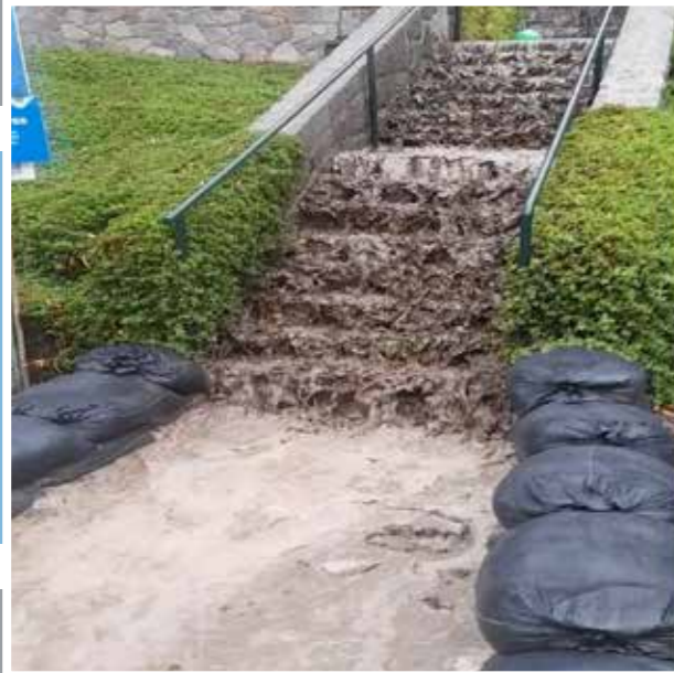
ELABORACIÓN DE COSTALILLOS CON ARENA PARA DELIMITAR MUROS DE CONTENCIÓN Y ENCAUZAR POSIBLES DESLIZAMIENTOS.
