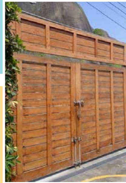
MANTENIMIENTO E INSTALACIÓN DE MARCO SUPERIOR DEL PORTÓN UBICADO EN LA ZONA DE PARRILLA
